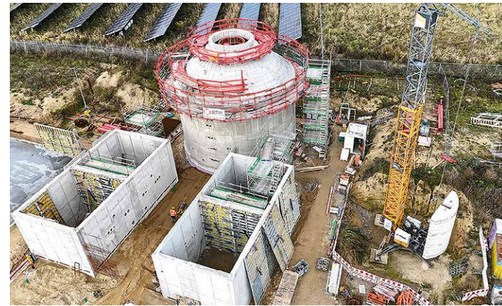
Achtung, Baustelle! Die Luftaufnahme von der Erweiterung der Kläranlage Zinnowitz zeigt den Faulturm mit den vier neuen Eindickern. Foto: ZV Usedom
