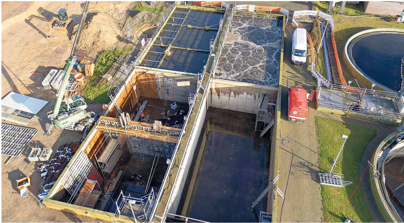
Die Luftaufnahme zeigt die beiden Belebungsbecken. Sie bleiben erhalten, werden aber nacheinander geleert, gereinigt und mit neuer Technik ausgestattet.
