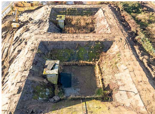
In diesen beiden Becken befanden sich noch die Überreste alter Anlagen aus DDR-Zeiten. Sie wurden abgerissen.
