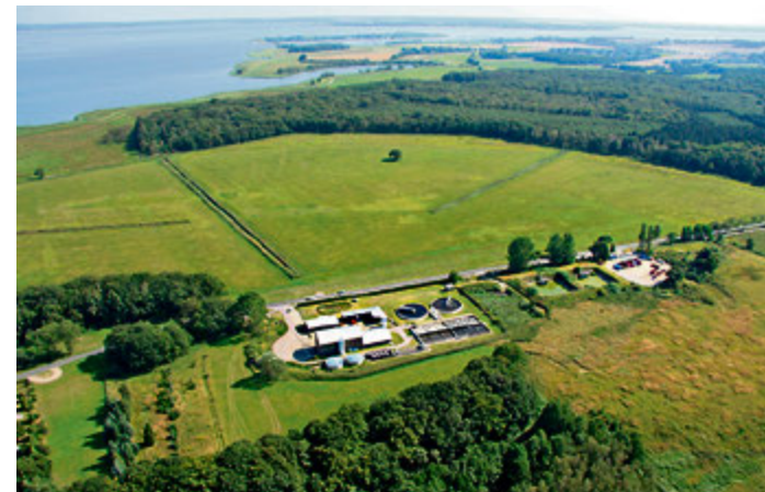
Die bestehende Kläranlage in Zinnowitz stößt an ihre Grenzen und soll erneuert werden. Foto: ZV Usedom/Spohler
