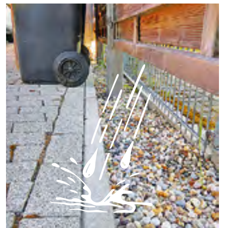
Ihr Nachbar wird für eine zusätzliche Traufkante an der Grundstücksgrenze dankbar sein, etwa wenn sich dort seine Auffahrt befindet. Sie selbst schützen sich davor, dass unerwünschtes Wasser rüber läuft.
