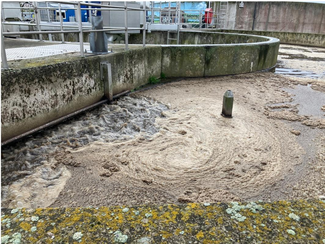
**Abbildung 1-5 Kombibecken Walzenbelüfter 1 mit Tauchmotorrührwerk**
