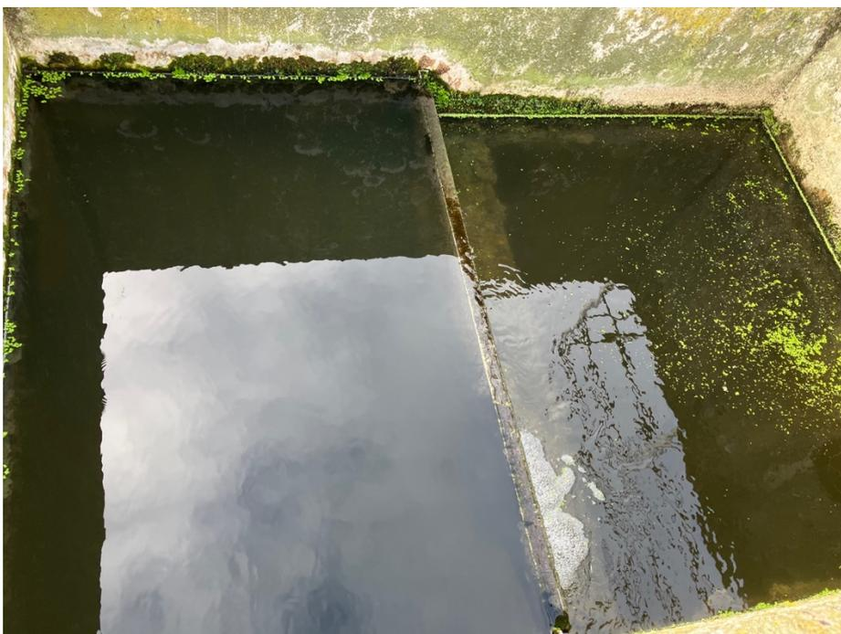
**Abbildung 1-8 Ablaufschacht mit höhenverstellbarem Überfallwehr**
