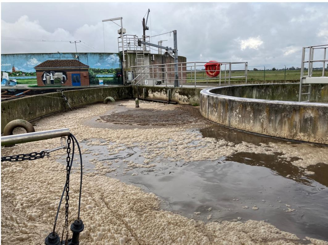
**Abbildung 1-6 Kombibecken Walzenbelüfter 2, Vordergrund: Sauerstoffsonde, Hintergrund: Schlammsilo**
