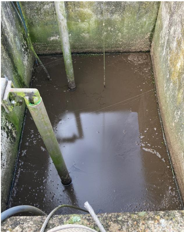
**Abbildung 1-7 Sammelschacht Rücklaufschlamm und Überschussschlamm mit Tauchpumpen**
