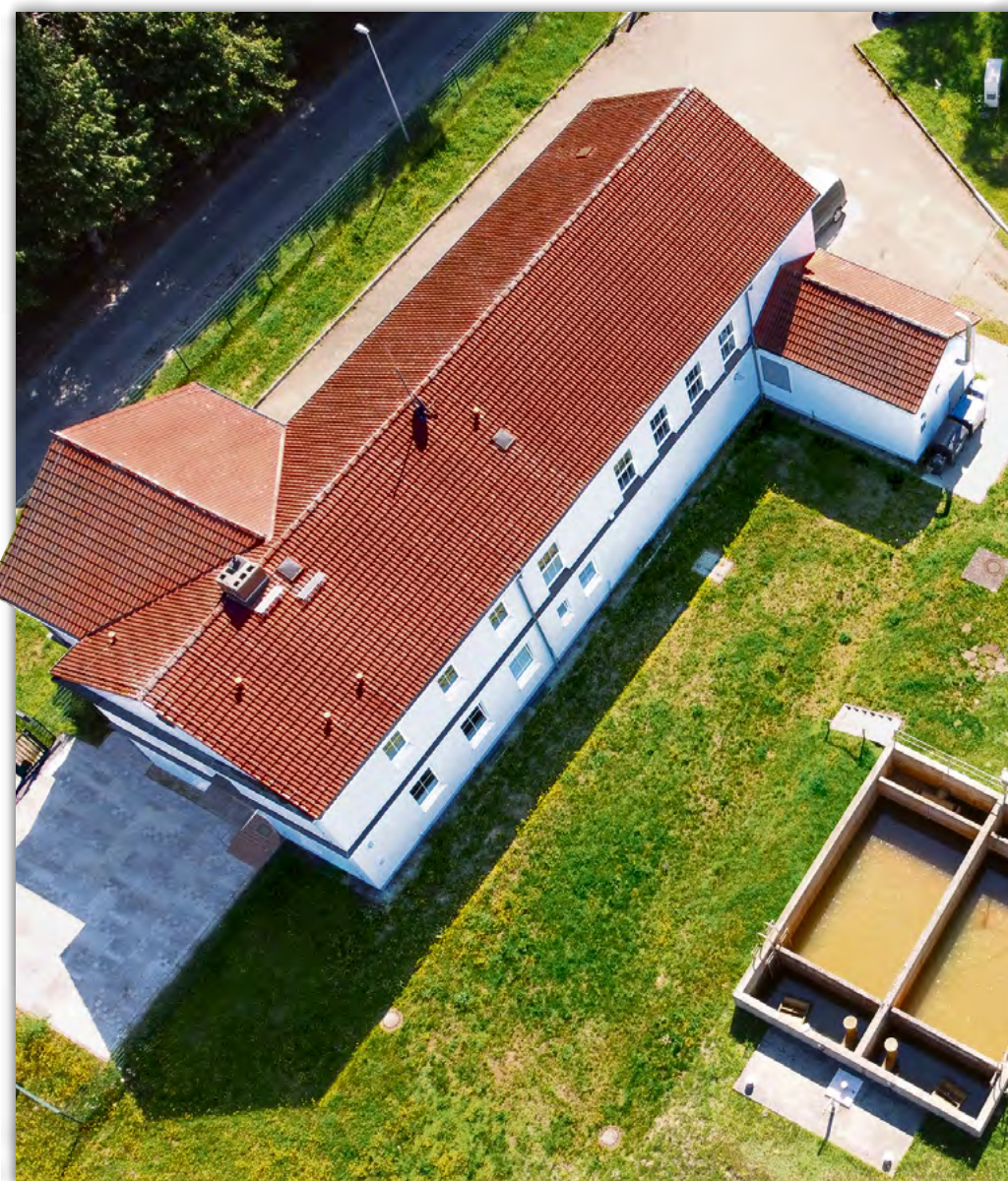
Das Wasserwerk Zinnowitz eignet sich sowohl vom Standort als auch der Dachfläche sehr gut für eine Photovoltaik-Anlage. Foto: Unitechnic
